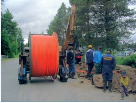
Valokuituputkea asennetaan maahan. Kuva: Nina Plogman.
