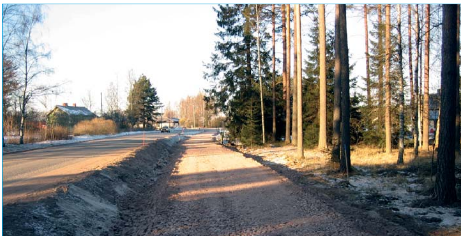
Kepolan-Ristolän pyörätie on hyvää vauhtia valmistumassa. Kuva: Pirjo Kotiranta.
